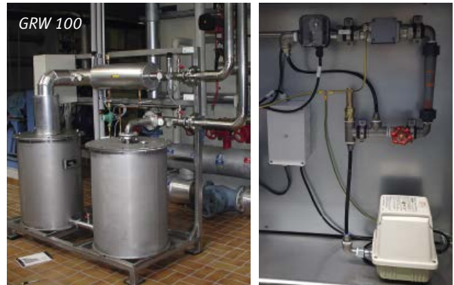
Abb. 2: Links eine Kompakteinheit zur Einstellung der optimalen Gasfeuchte mit anschließender Aktivkohlereinigung (GRW100), rechts eine TÜV-zertifizierte Luftdosierung (Fotos: Siloxa AG)
