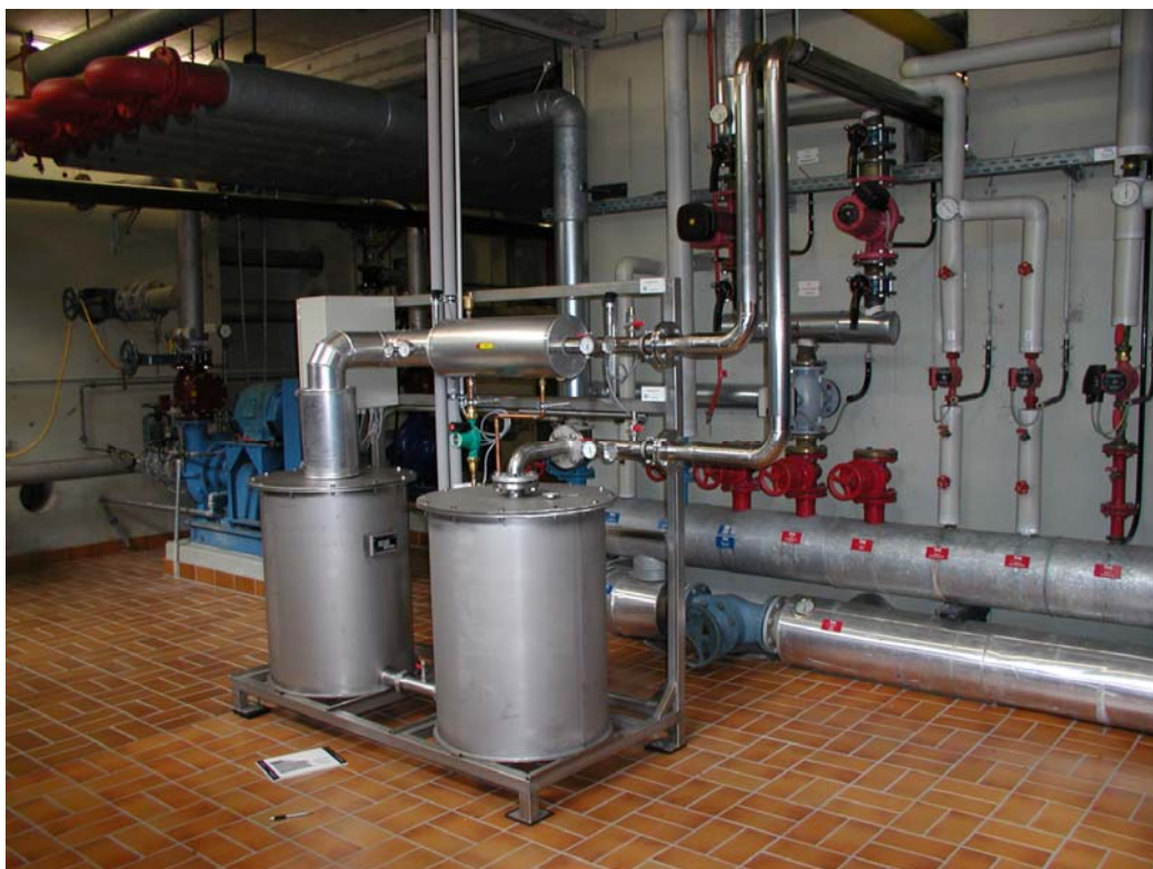
Abbildung 3: SILOXA-Wechselfiltersystem MAK 100.
